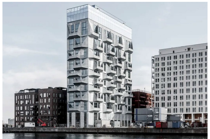
Silo Cobe, Nordhavn
