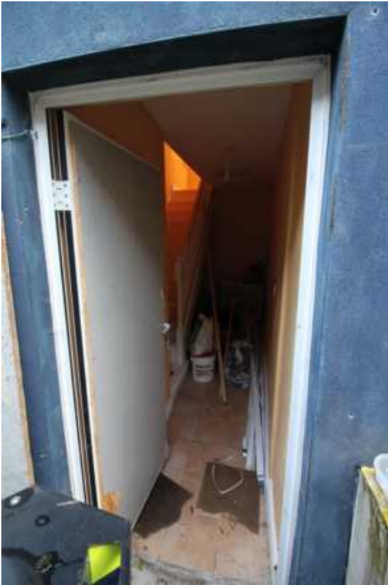
• Fig 27. Door GF3.
