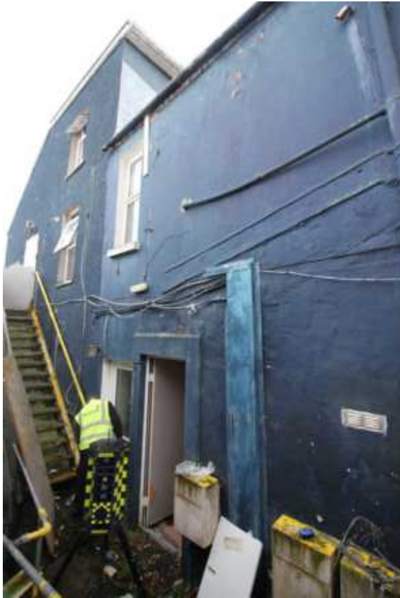
• Fig 26. Door GF 3. Door FF1 above.
