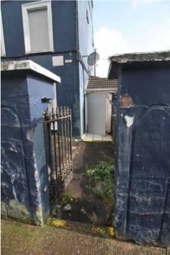
• Fig 28. Door GF1 inside gate.
